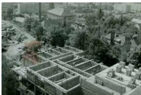
Obrázek 2 - Výstavba domova mládeže
